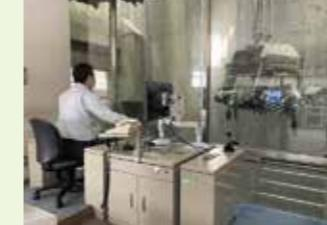
ごみクレーンの自動運転(ピット内のごみの攪拌、ごみのならし、自動投入)および投入量の演算を行ないます。
