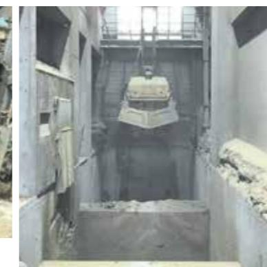
■不燃物ピット&固化物ピット&灰クレーン
